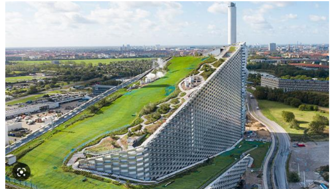
Amager Ressource Center Kopenhagen von der Bjarke Ingels Group
