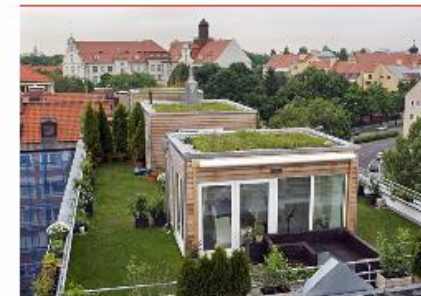
ABBILDUNG 6: KOMBINATIONSBAUWEISE GRÜNDACH UND DIPV, QUELLE: GRÜNSTATTGRAU.AT.
