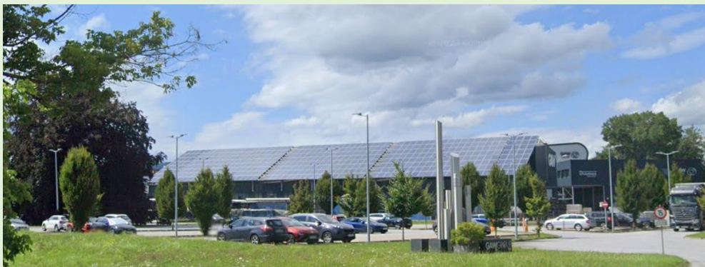
Abbildung 6: Beispiel einer Photovoltaikanlage (Heigl Consulting ZT GmbH)
